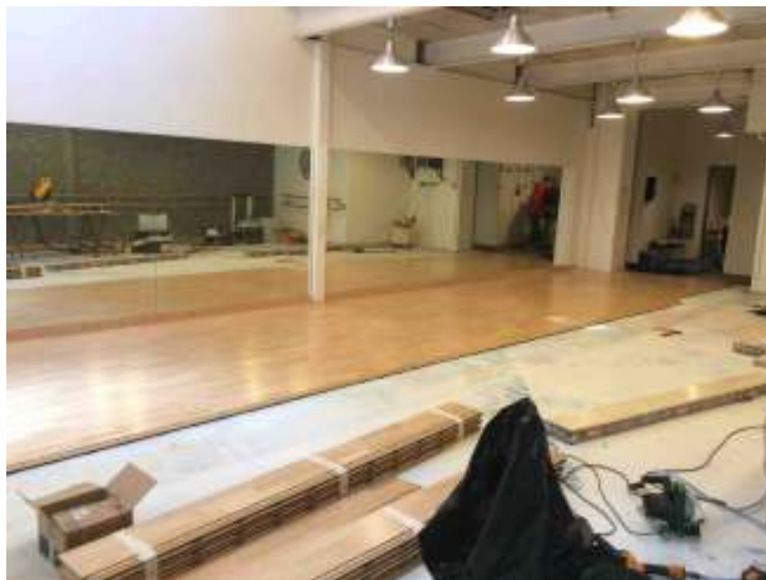
Attivita version hêtre en cours de pose
